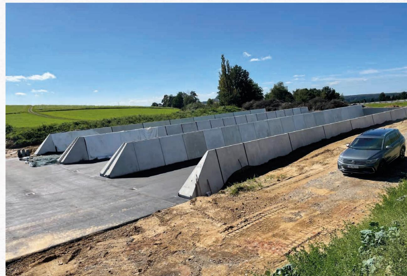
Fahrsiloanlage, bestehend aus A-Form in 2,50 m Rohmaßhöhe als Außenwände und AW-Form in 2,50 m Rohmaßhöhe als Mittelwände mit je 45 m Länge. Anfangselemente abgeschrägt.
