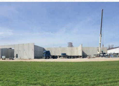
Setzen der Betonfertigwände mit einem Kran
